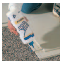
Påføring af Rigidur Gulvlim i falsen.
